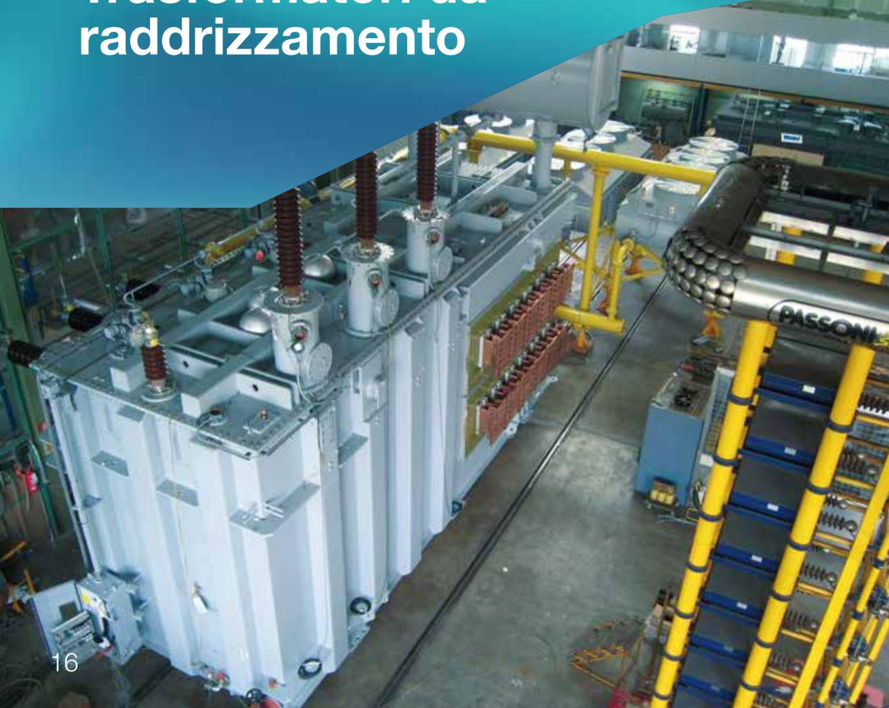
Il trasformatore da raddrizzamento è il collegamento tra la rete elettrica e il convertitore CA/CC. Pertanto, ha lo scopo di fornire il numero di fasi, gli sfasamenti di tensione necessari per realizzare la conversione e di regolare l'ingresso del raddrizzatore per variare la tensione di uscita CC.
